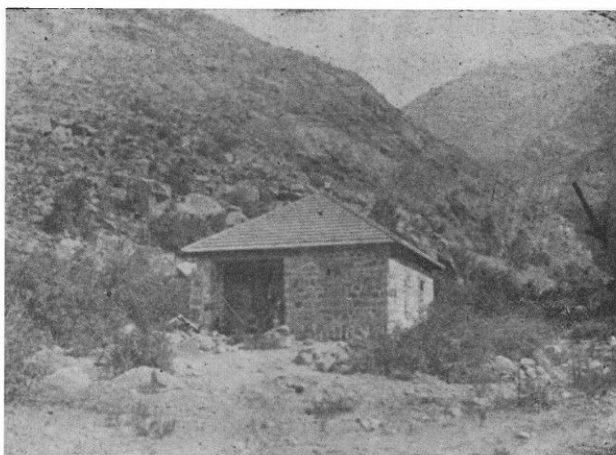
Casa para el guarda toma en Riecillos
